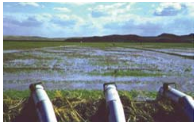
(d) Large diameter siphon tubes
