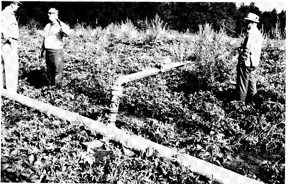
Figure 3-8.--Big-gun sprinkler.
